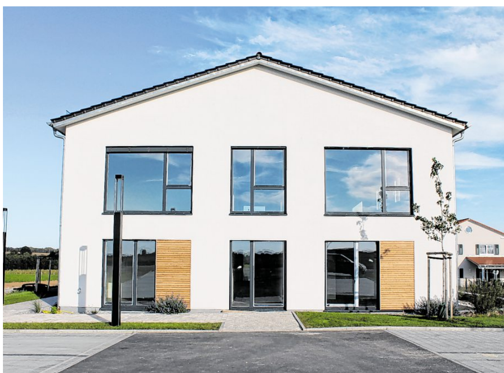
Nun ist das Gesundhaus endlich fertig. Lediglich im Gebäude werden letzte Arbeiten durchgeführt. Ende Oktober wird es dann offiziell eröffnet. Foto: Lena Brandner
